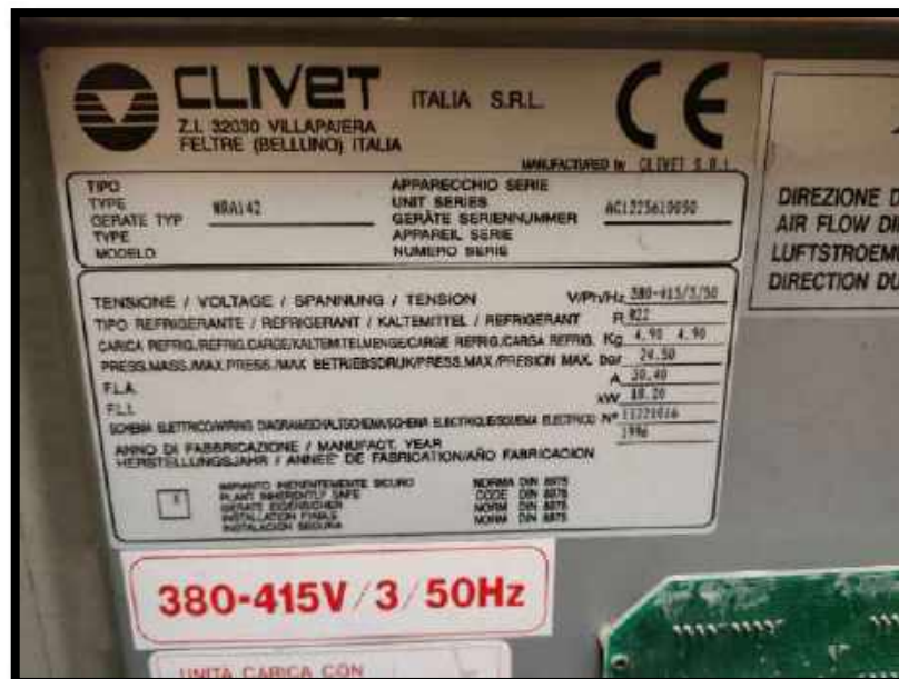
Figura 5 - Targa del gruppo frigo installato
